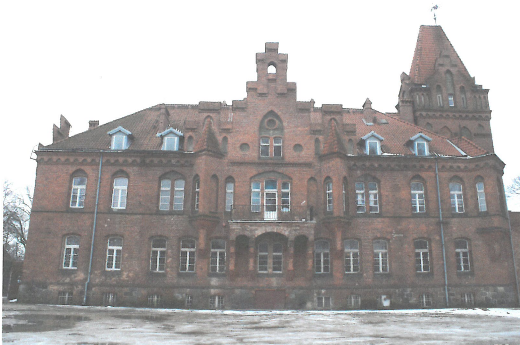
Fot.1 – Widok ogólny budynku od strony półn.-wsch.
