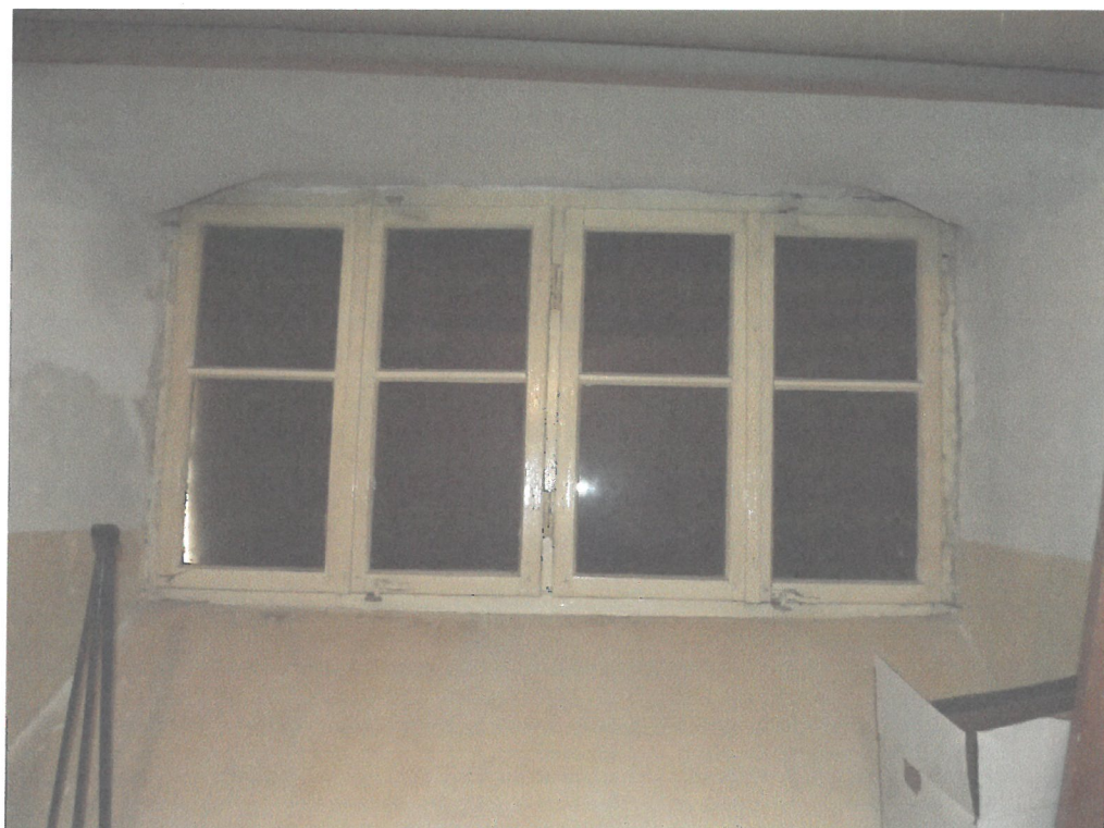
Fot.7– Okna piwniczne przerobione na wysp opału
