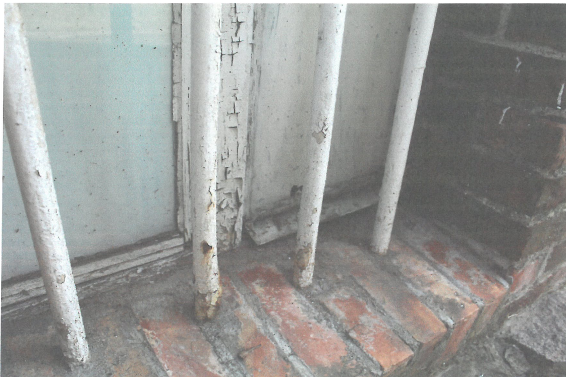
Fot.2– Stolarka okienna piwnicy
