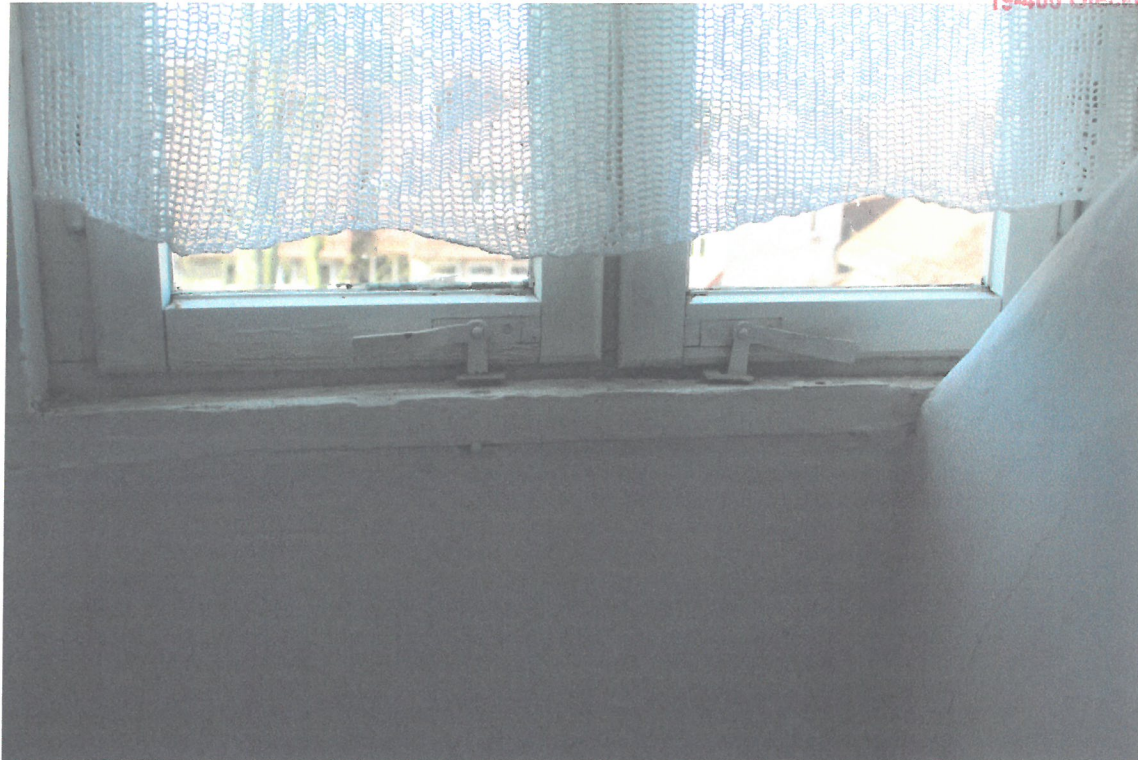
Fot.4– Okno poddasza
