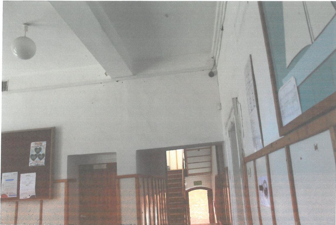
Fot.9– Tynki wewnętrzne ścian i sufitów
