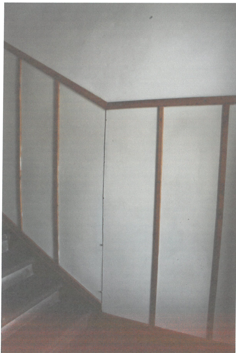
Fot.8- Lamperia na klatce schodowej
